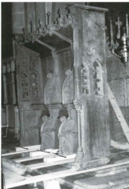
Außerdem mußte eine zusätzliche Unterkonstruktion aus Eichenholz gefertigt werden, auf der dann anschließend das Chorgestühl geschoben werden sollte. Nachdem der Levitensitz an der Rückwand mit Kräuteressig gegen Wurmbefall imprägniert worden war, konnte er in seine ursprüngliche Position zurückversetzt und abgesenkt werden. Abschließend
