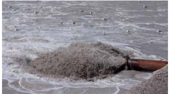
Bild (N. Grüneberg) Mit einem Druck von 7 bar wird das Wasser-Sand-Gemisch durch die Rohre auf den Strand gepumpt und dort mit Planierraupen verteilt.
