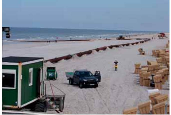
Bild (N. Grüneberg) Mit einem Druck von 7 bar wird das Wasser-Sand-Gemisch durch die Rohre auf den Strand gepumpt und dort mit Planierraupen verteilt.
