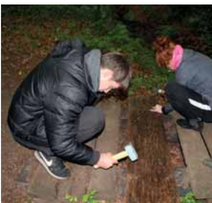
(N. Grüneberg) Die Brücke wird wieder repariert.
