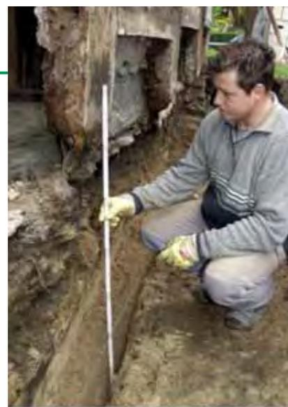
Bild (K. Piepenbrock): Neue Gründung der angekübhten Ostwand
