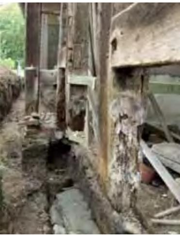
Bild (K. Piepenbrock): Die Grundmauer auf der Westseite wurde im „Sandwich“-Verfahren von zwei Seiten mit einer neuen Gründung versehen.
