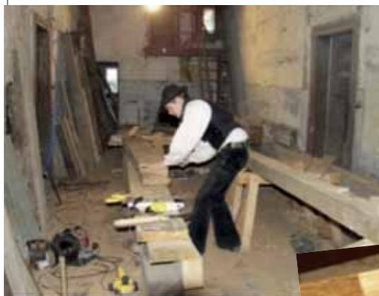
Bild (K. Piepenbrock): Fachgerechte Erneuerung und Reparatur des Fachwerks
